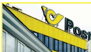
1 Im Gebäude und Fuhrpark
